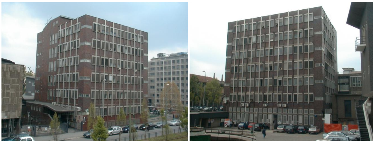
Figura 1. Foto delle facciate Sud e Ovest (a sinistra) e della facciata Est (sinistra) dell'edificio in esame.
