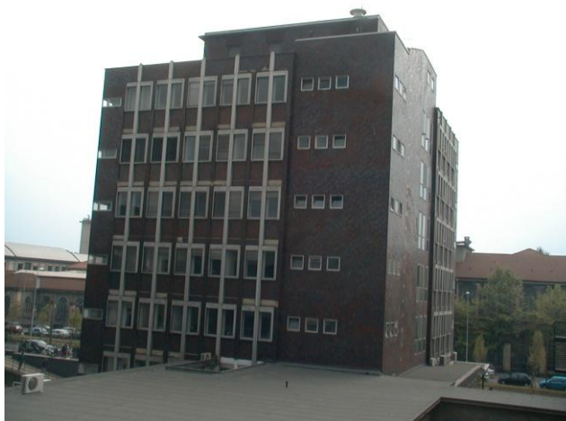
Figura 2. Foto della facciata Nord dell'edificio in esame.
