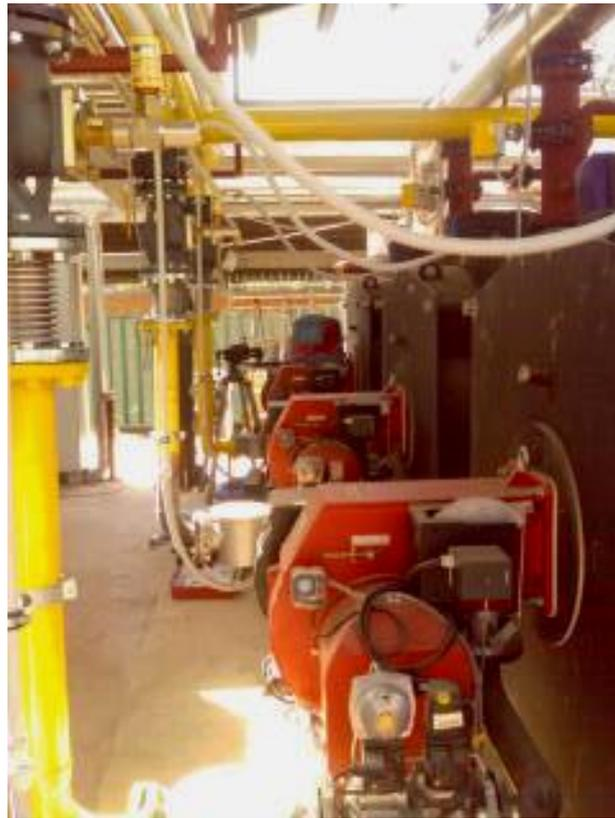
*Fig.1.9 – Caldaie a gas del polo termo-frigorifero*
