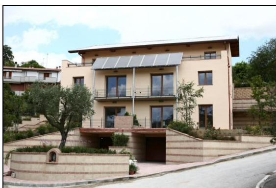
Fig. 1 - Facciata sud della LH
