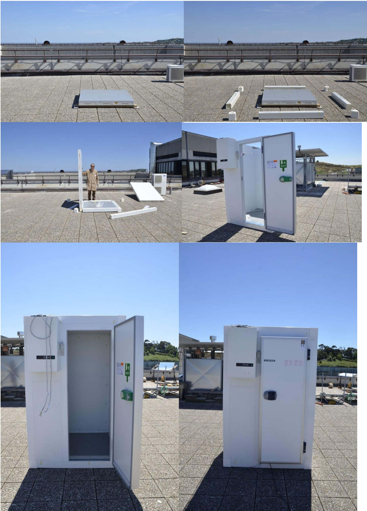
Figura 28 sequenza della costruzione delle celle frigorifere
