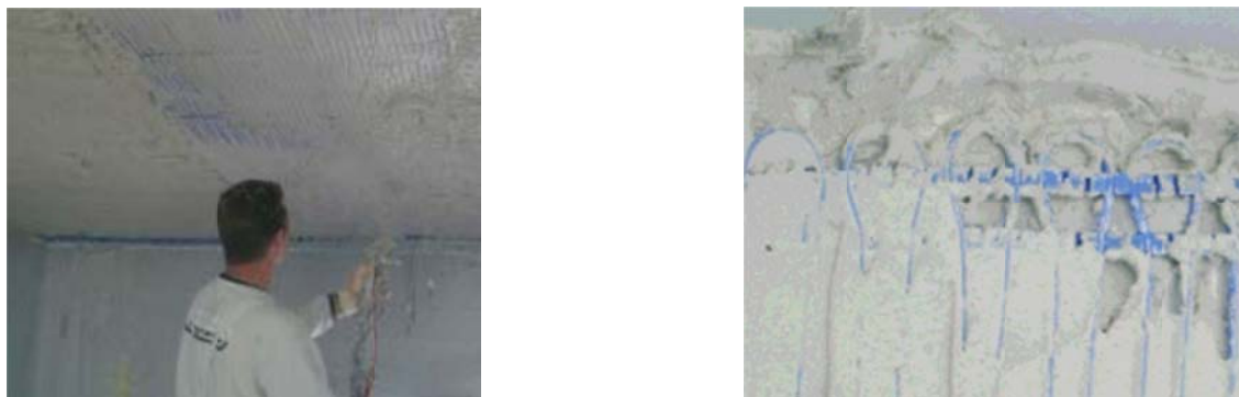
Figura 3:impieghi in edilizia- intonaci
