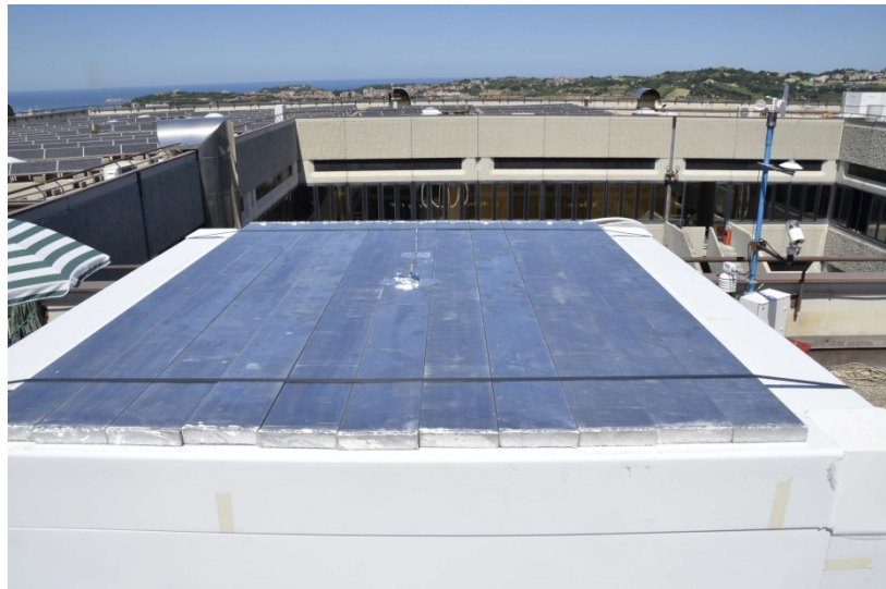
Figura 25 Contenitori PCM su cella frigorifera in condizioni statiche
