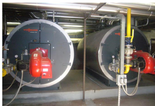
Figura 13: Caldaie Vitomax 200 tipo M241
