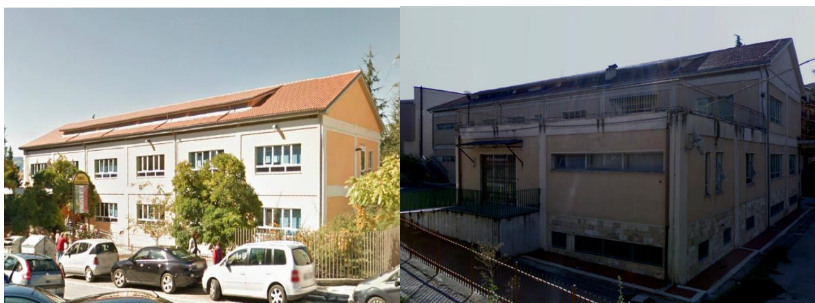
Figura 4: Scuola elementare, vista Ovest ed Est.
