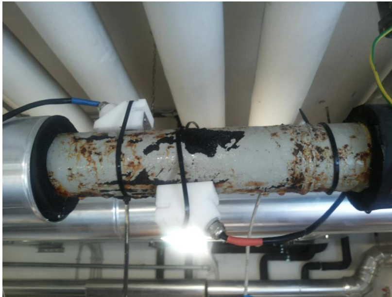
Figura 94: Particolare dell'installazione dei due sensori di portata a ultrasuoni cimap -on
