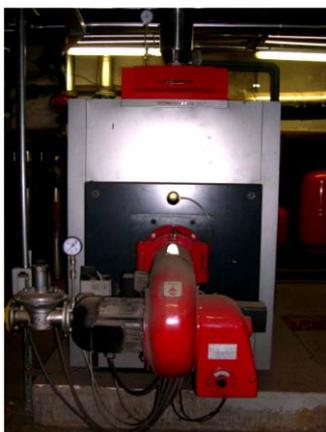
Figura 7 - Caldaia Viessmann Vitocrossal 300 tipo CR3
