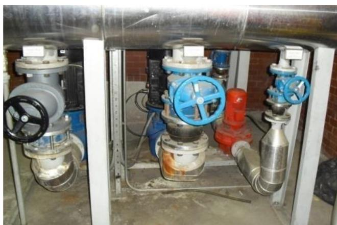
**Figura 17 - Pompe del circuito di teleriscaldamento**
