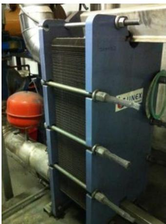
**Figura 12: Scambiatore di calore lato circuito palazzina uffici**
