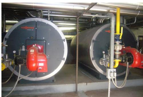
Figura 8 - Caldaie Vitomax 200 tipo M241
