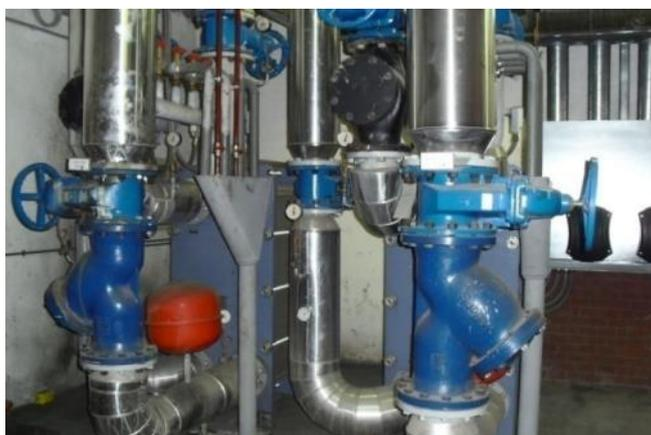
**Figura 16 - Scambiatori di calore lato circuito di teleriscaldamento**
