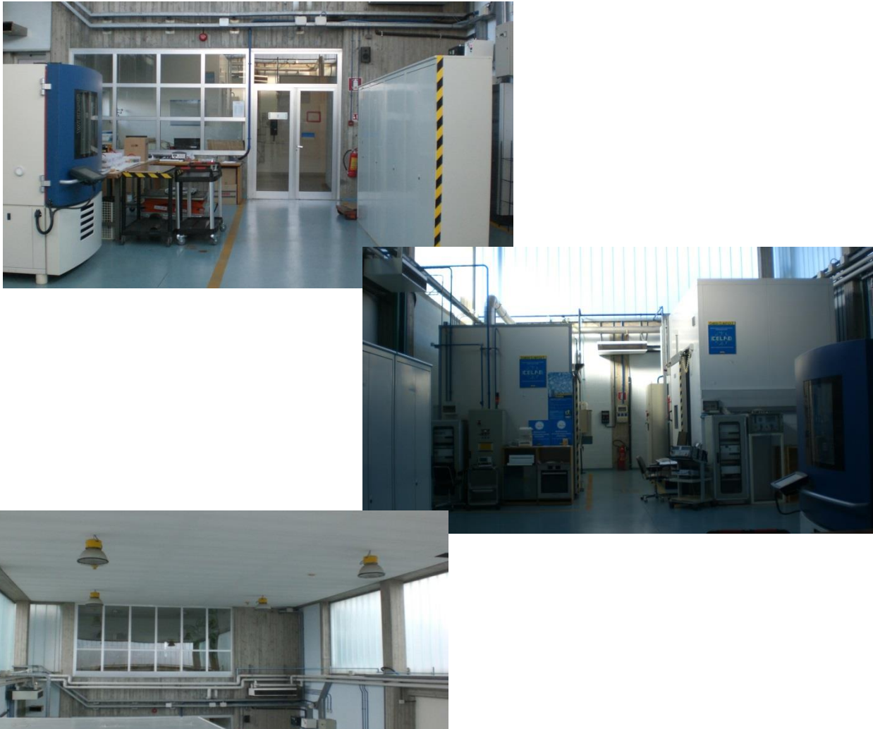
Figura 2. Viste interne della Hall tecnologica prima dell'intervento
