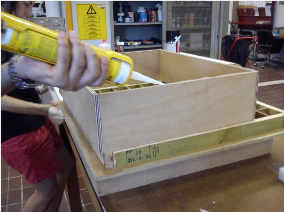
**Figura 2.2.4: Applicazione sigillante per la chiusura del pannello.**
