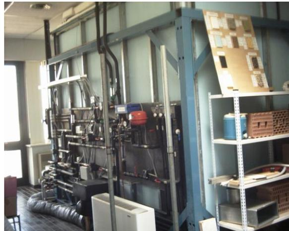
**Figura 53. Particolari costruttivi della camera : il sistema di regolazione idronico**
