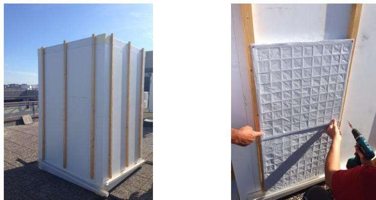
Figura 66. Prime fasi del montaggio dei contenitori di PCM
