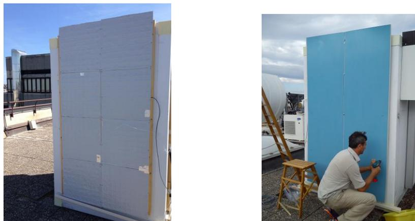
**Figura 67. Chiusura con il lamierino di finitura esterna delle pareti della cella frigo di prova**
