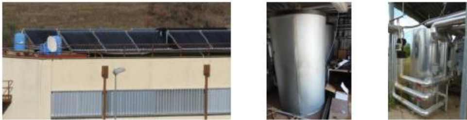
Figura 1 – Componenti principali dell'impianto di Solar cooling.
