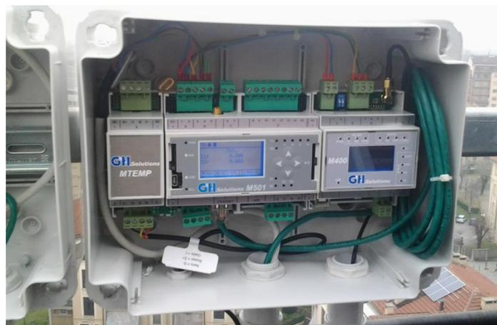
**Figura 107: immagine del sistema installato nella rete termica monitorata per il convogliamento e trasferimento della misure di energia termica dei singoli pie di stabile in protocollo Modbus su TCP/IP**
