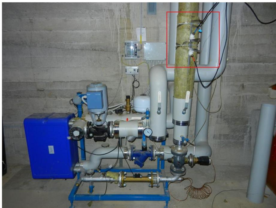
**Figura 88: installazione sensori di portata clamp on per misurare la portata in ingresso alla sottostazione**
