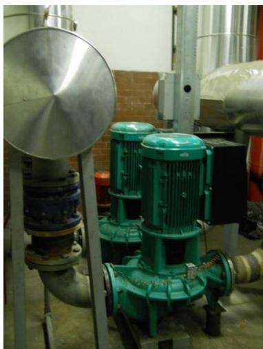
**Figura 16 - Pompe del circuito di teleriscaldamento**
