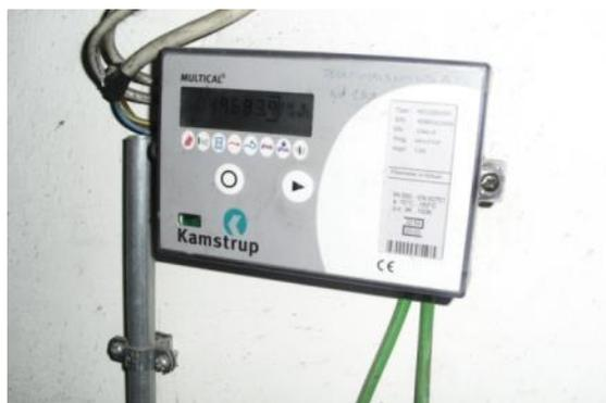
**Figura 17 - Misuratore di calore nr.9**
