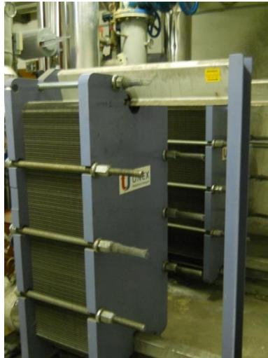
**Figura 15 - Scambiatori di calore lato circuito di teleriscaldamento**
