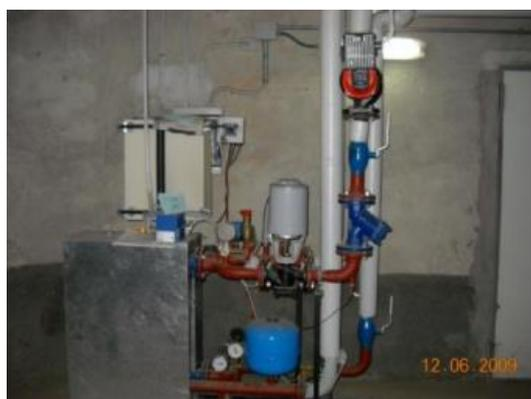
**Figura 27 - Piè di stabile con sottostazione di scambio**
