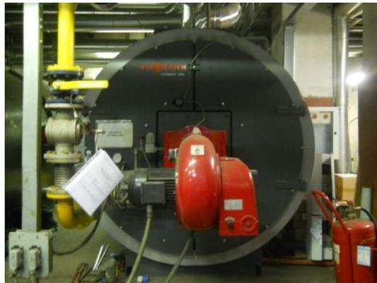
**Figura 7 - Caldaie Vitomax 200 tipo M241**
