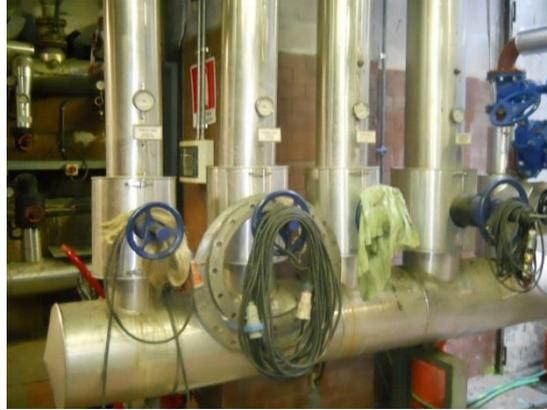
**Figura 14 - Collettore circuito palazzina uffici**
