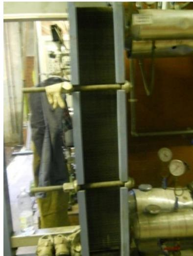
**Figura 11 - Scambiatore di calore lato circuito palazzina uffici**
