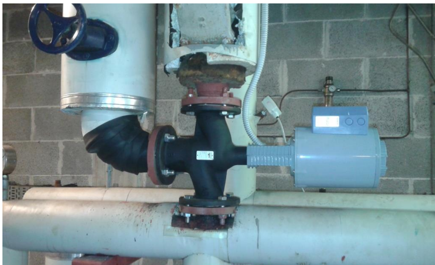
Figura 114 - Centrale termica F40, sostituzione valvola a tre vie circuito estivo
