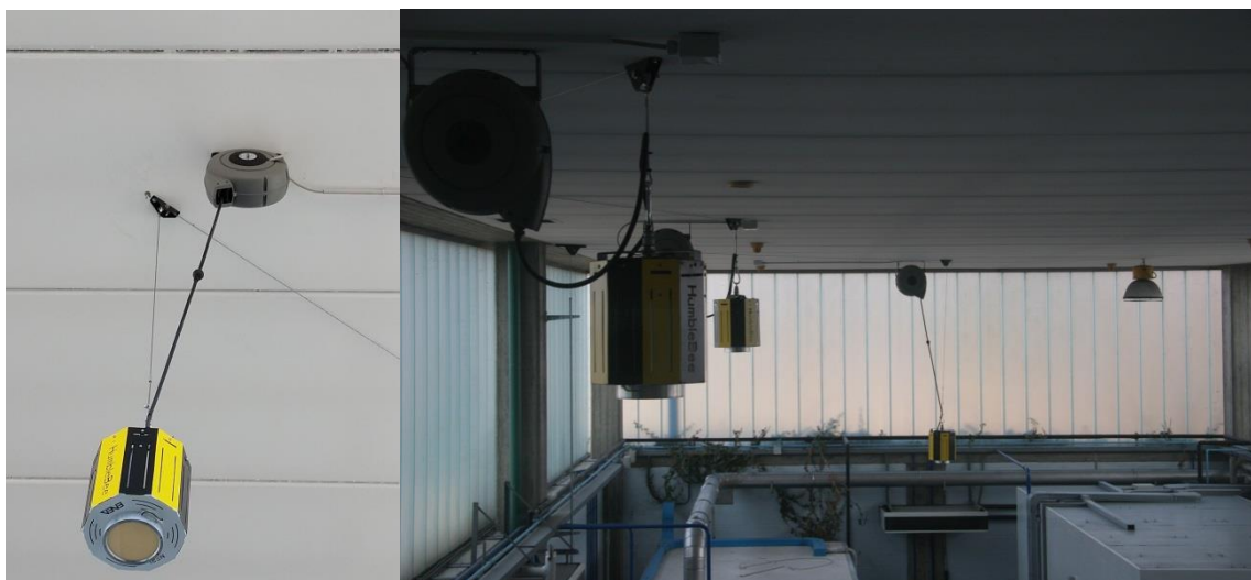
Figura 23: Installazione di carrucole per la movimentazione degli apparecchi
