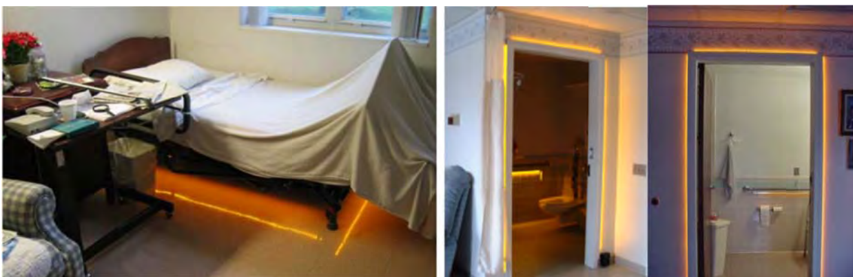
Figura 15 - Sistema di illuminazione customizzato a LED ambra per il letto e per la cornice del bagno
