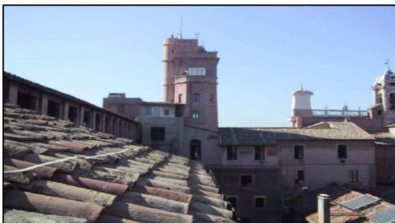
Fig.3: Collegio Romano, Torre Calandrelli
