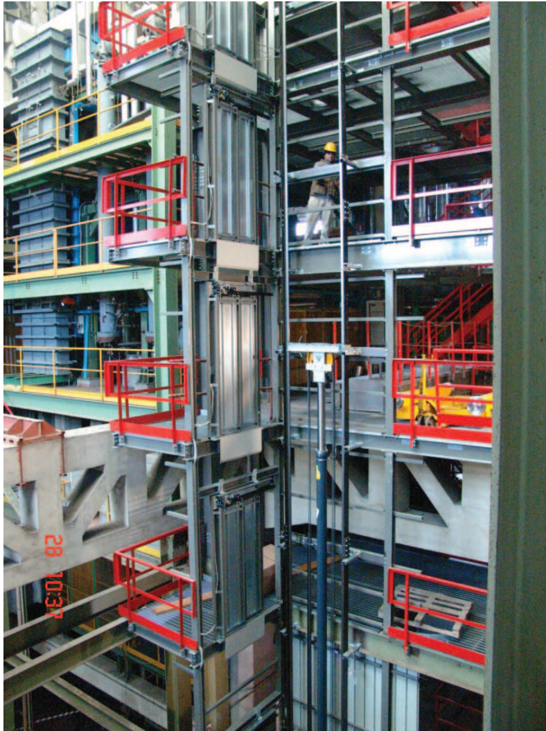
Fig. 8 - Struttura portante SPES-3
