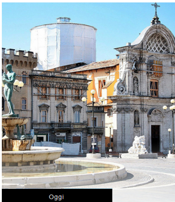
Figura 9a,b,c. Evoluzione dei lavori nel centro storico.
