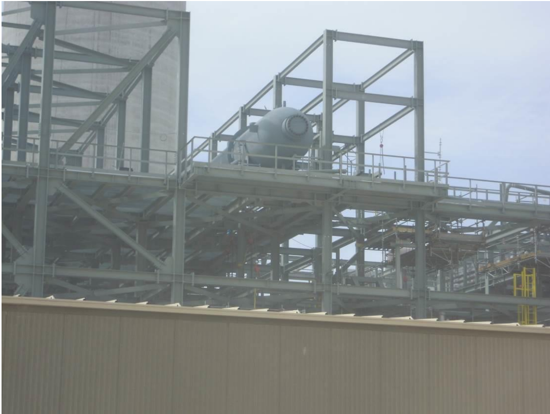
Figura 11: Particolare del Generatore di Vapore (Corpo Cilindrico)
