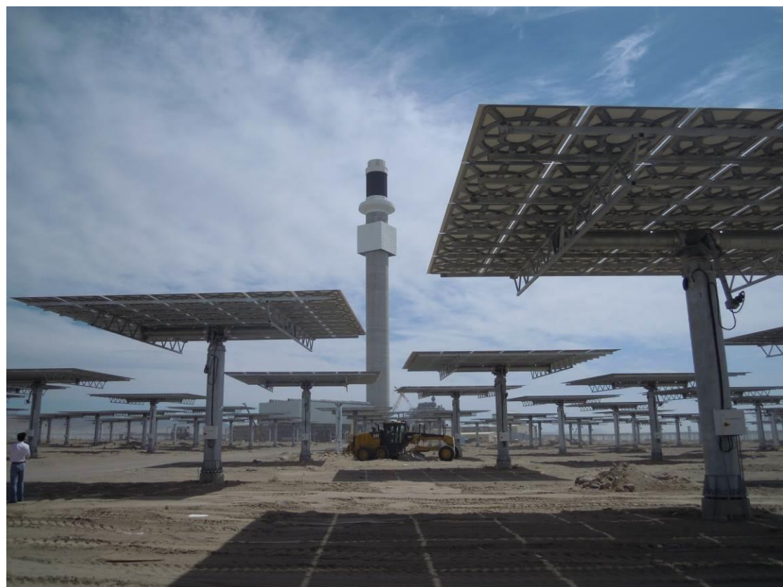
Figura 8: La torre fra gli eliostati; la parte cilindrica nera contiene il ricevitore a sali fusi; la parte bianca sotto serve per metter a punto la focalizzazione degli eliostati
