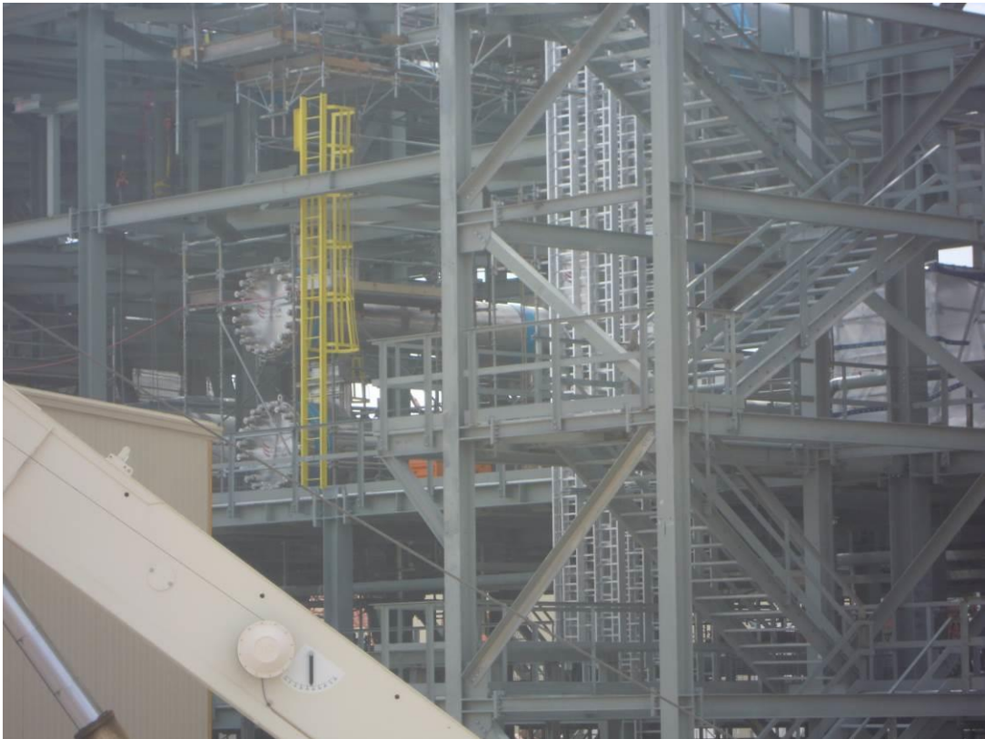
Figura 10: Particolare del generatore di Vapore
