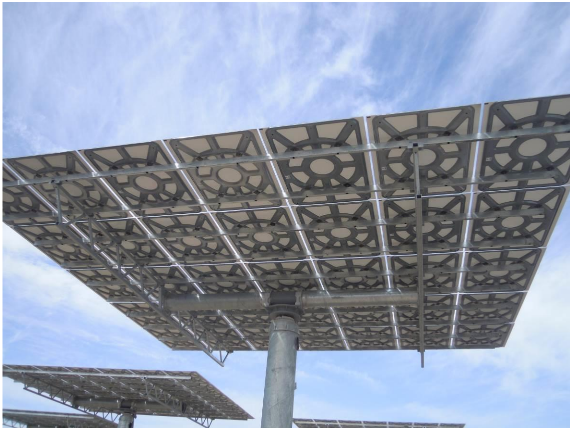
Figura 6: Eliostato: è costituito da 35 specchi piani
