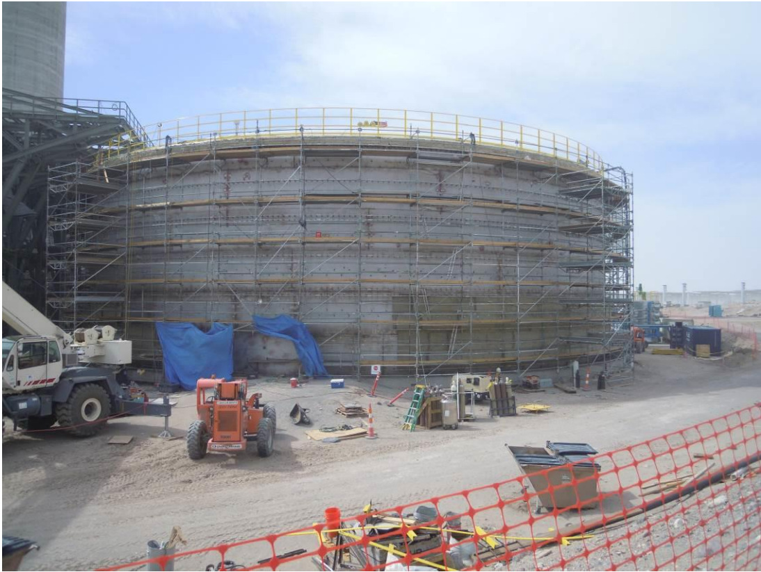
Figura 9: Uno dei due serbatoi in fase di coibentazione
