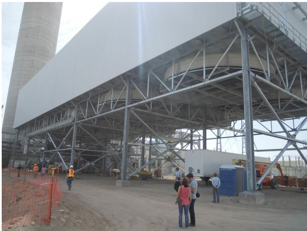
Figura 12: Sezione condensatore raffreddato a secco
