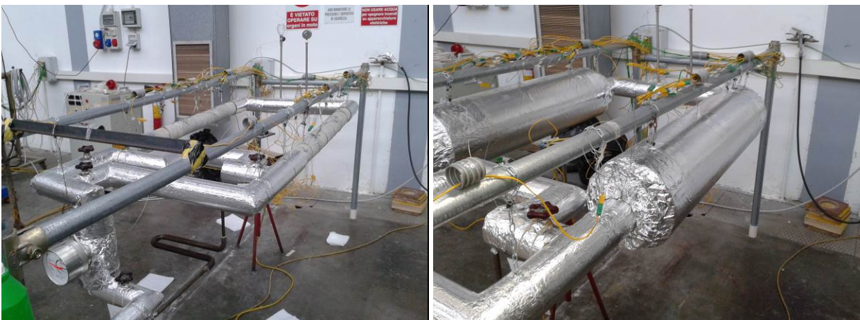
Figura 4- Assetto elementi di accumulo privi di coibentazione durante il test di degasaggio e coibentati pronti per i ciclaggi di carico e scarico.
