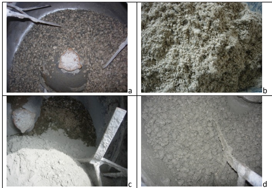
Figura 2 – Fasi di confezionamento del calcestruzzo: a) aggregato e trucioli metallici, b) sabbia 0-7 e fibre di nylon, c) cemento, d) impasto prima del test di abbassamento del cono.
