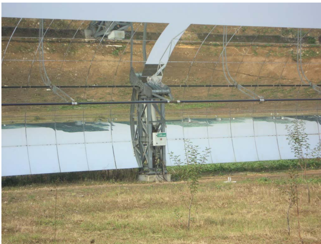
Fig. 6 – Dettaglio del collettore parabolico lineare sperimentale da 100 m.
