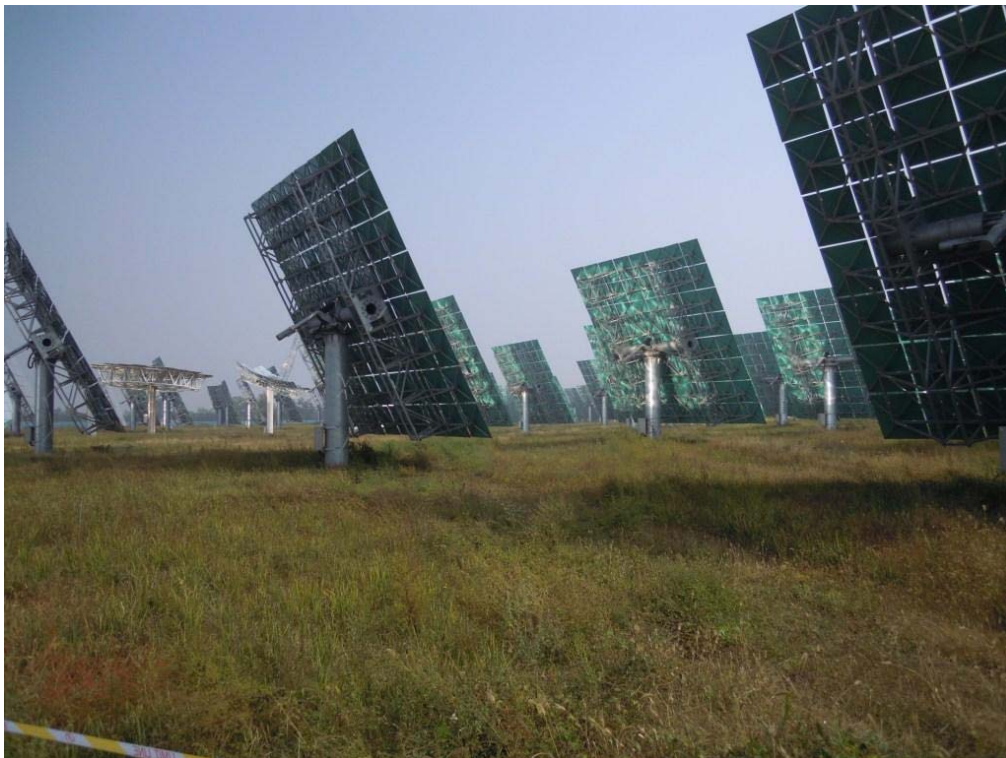
Fig. 4 – Veduta posteriore degli eliostati
