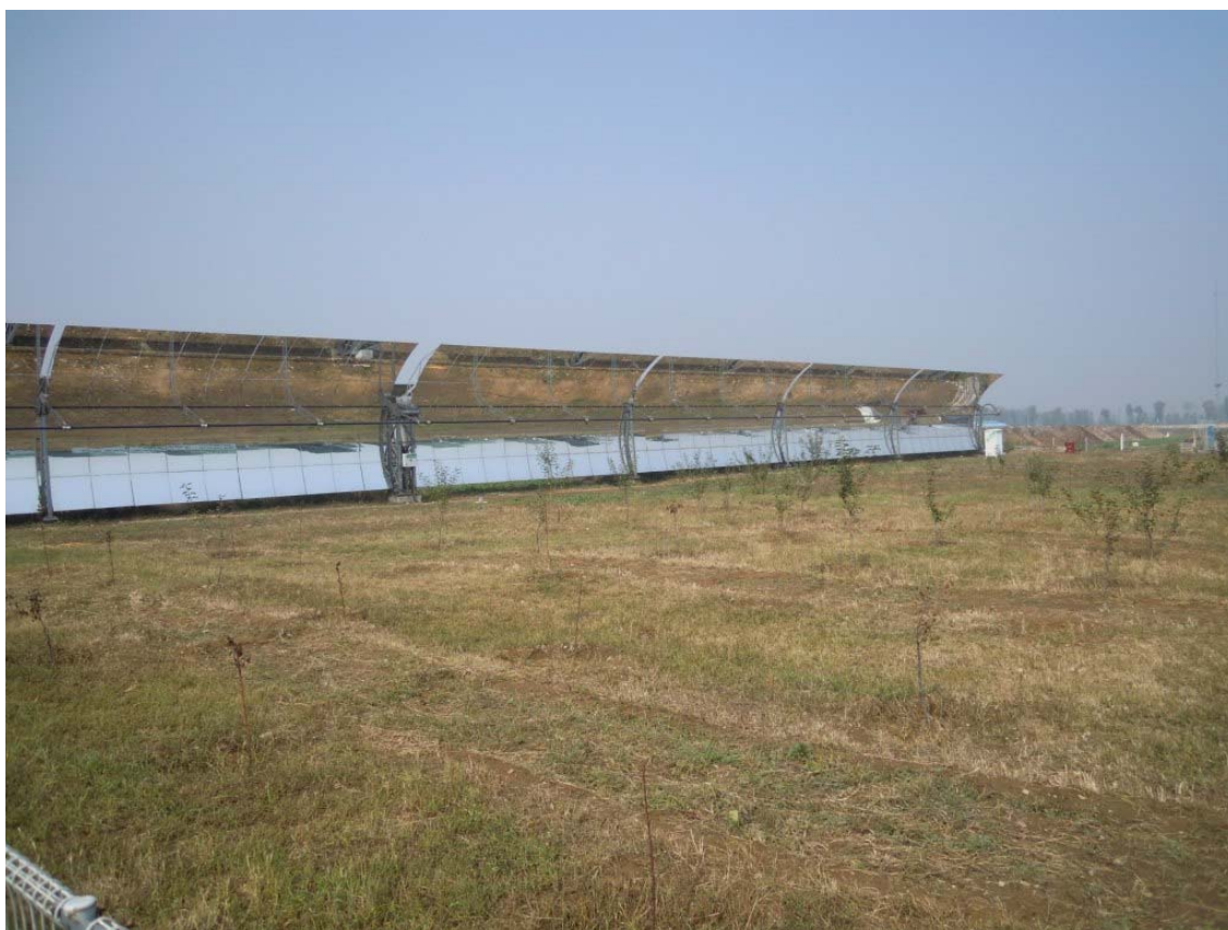
Fig. 5 – Collettore parabolico lineare sperimentale da 100 m.
