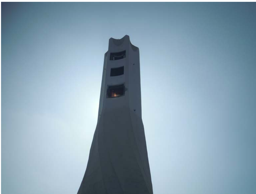
Fig. 2 – La torre solare; il ricevitore inferiore, a vapore, è illuminato da alcuni eliostati a scopo dimostrativo
