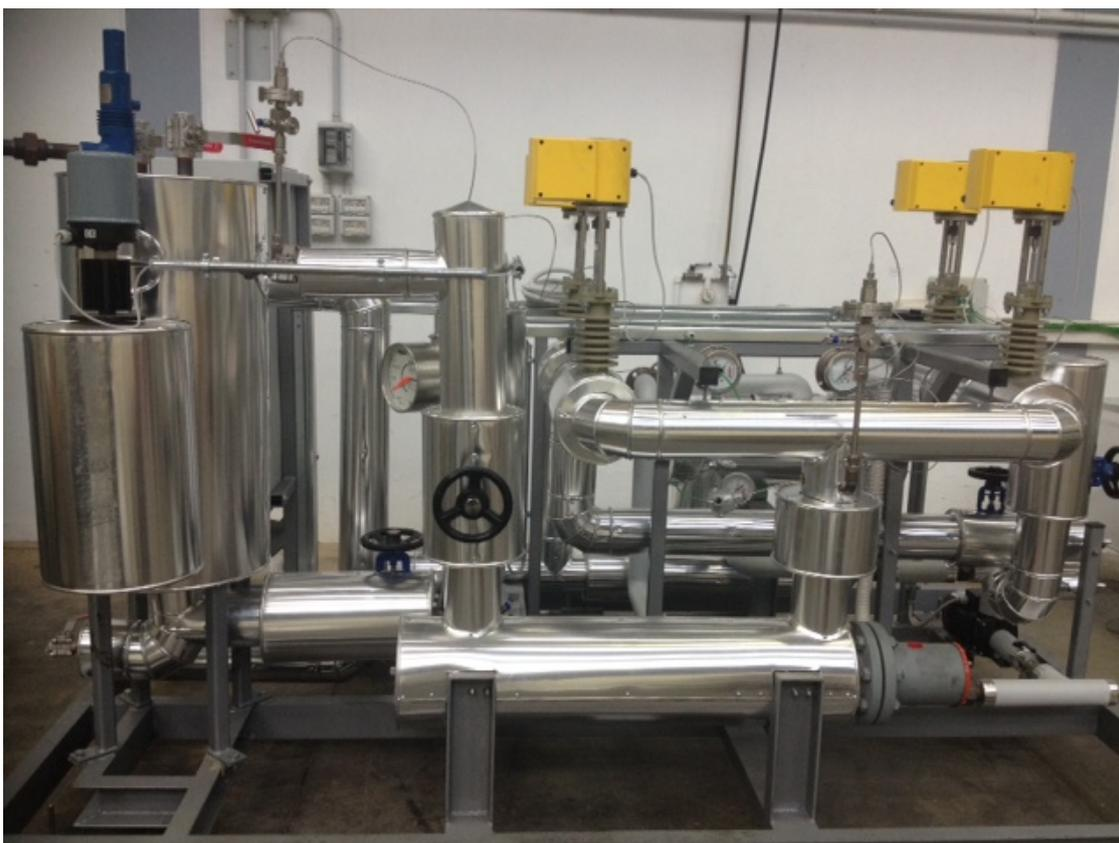
Figura 11: vista della sezione di riscaldamento dell'impianto Solteca3.
