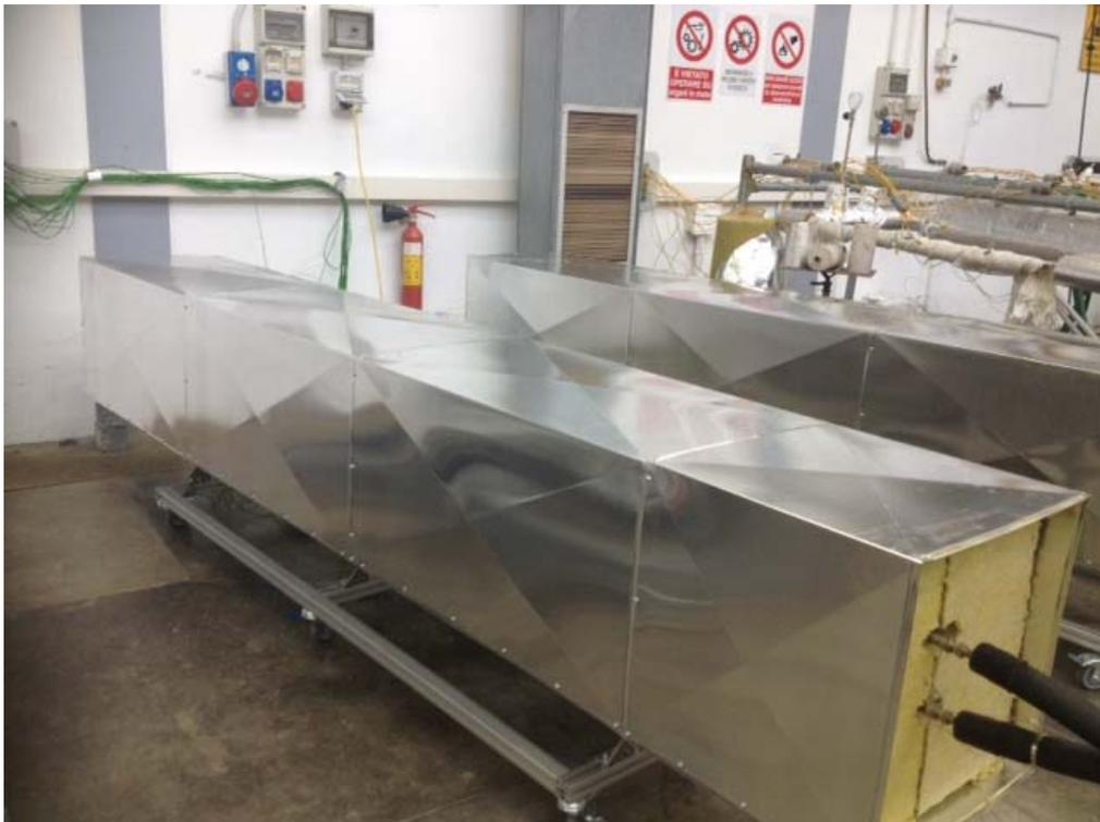
Figura 18: particolare del sistema di accumulo con coibente e lamierino.
