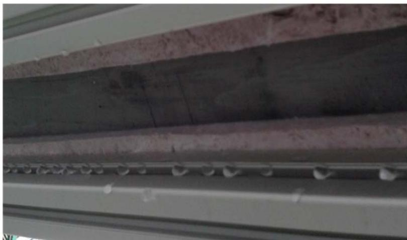
Figura 30: Condensazione del vapore acqueo sulla barra di sostegno.
