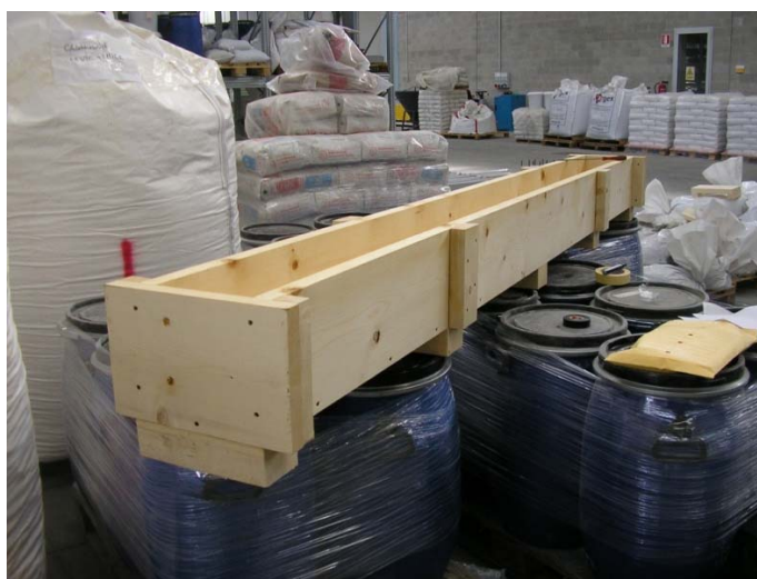
Fig. 10 Cassero in legno impiegato per la realizzazione del getto.
