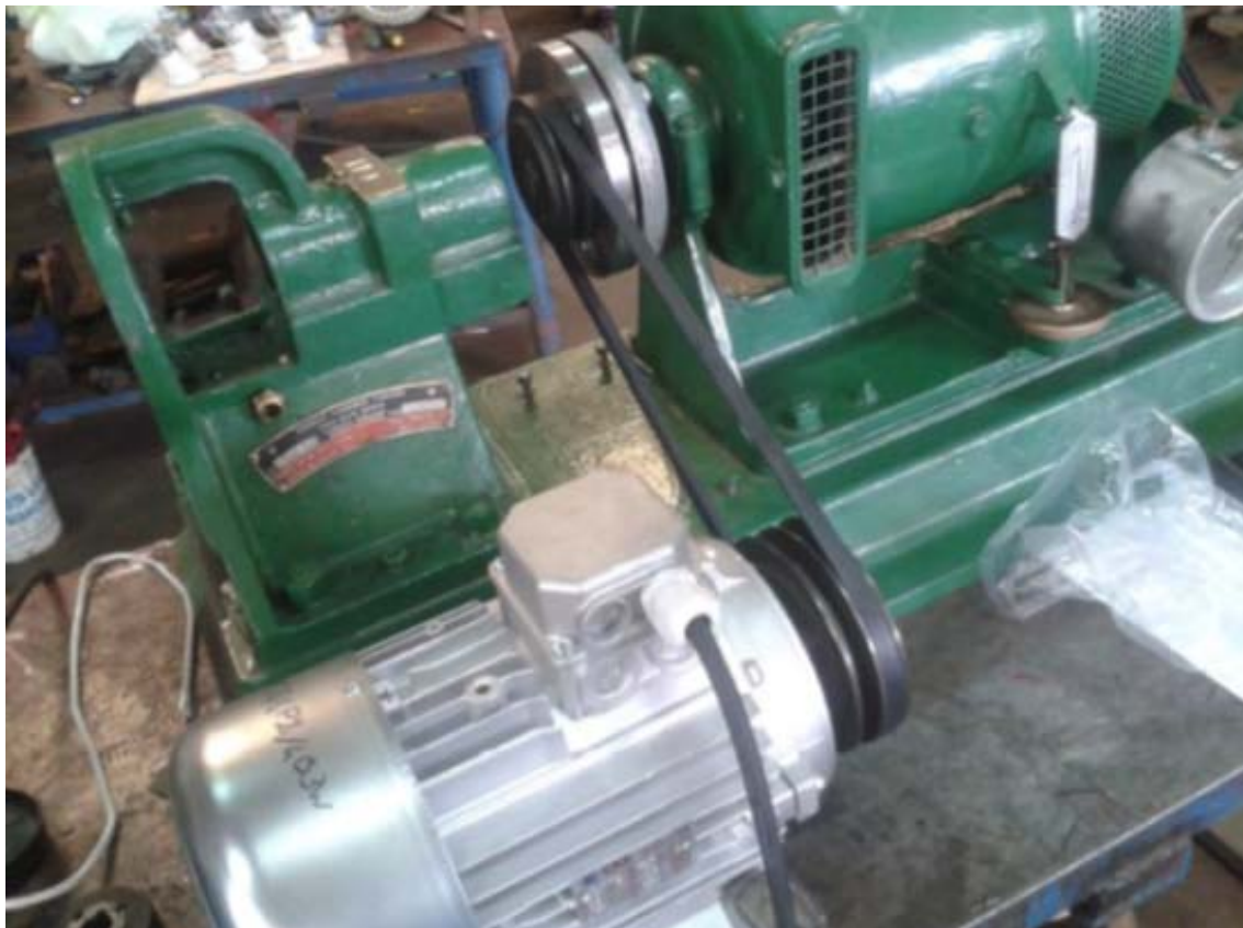
Figura 2-6 Prova del generatore elettrico della turbina: particolare dell'accoppiamento al motore
