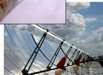
Tube in acciaio: **AISI 321**; Lunghezza = 4060 mm, Diametro = 70 mm
