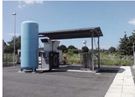
Piazzola produzione aria compressa
