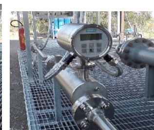
Misuratore di portata con visualizzazione in campo e gestita da DCS
