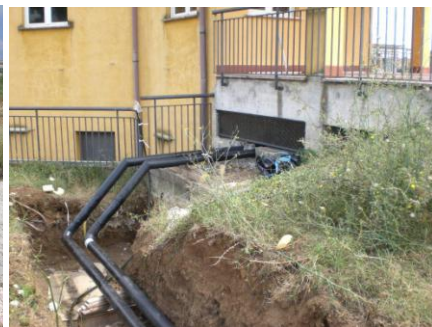
Fasi realizzative impianto di solar heating and cooling innovativo su Edificio F92
