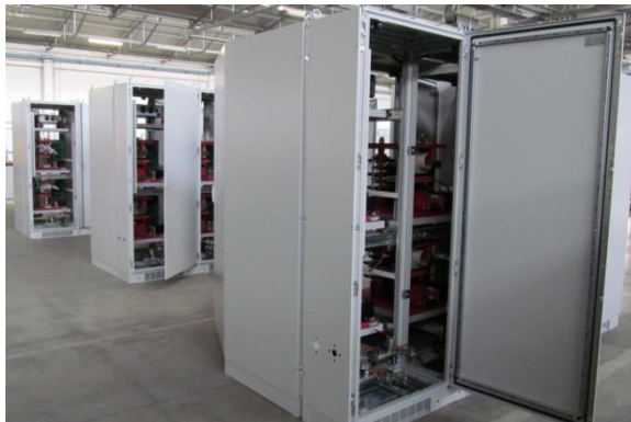
Raffreddamento dei semiconduttori con acqua demineralizzata.
