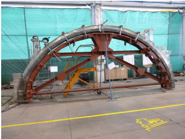
2° gamba curva in lavorazione
