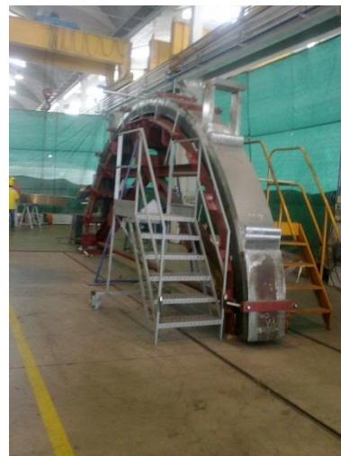
Saldatura accessori su gamba curva (ALSTOM-C)
