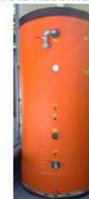
SERBATOIO ACCUMULO CALDO
