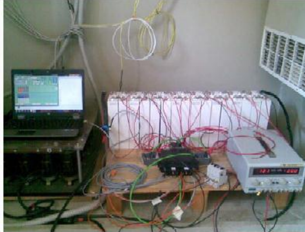
BMS n. 2 (di tipo semiattivo) in esercizio
